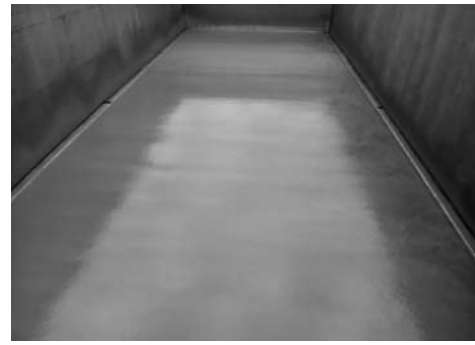
Рис. 1. Полимочевинное покрытие днища вагона думпкара
