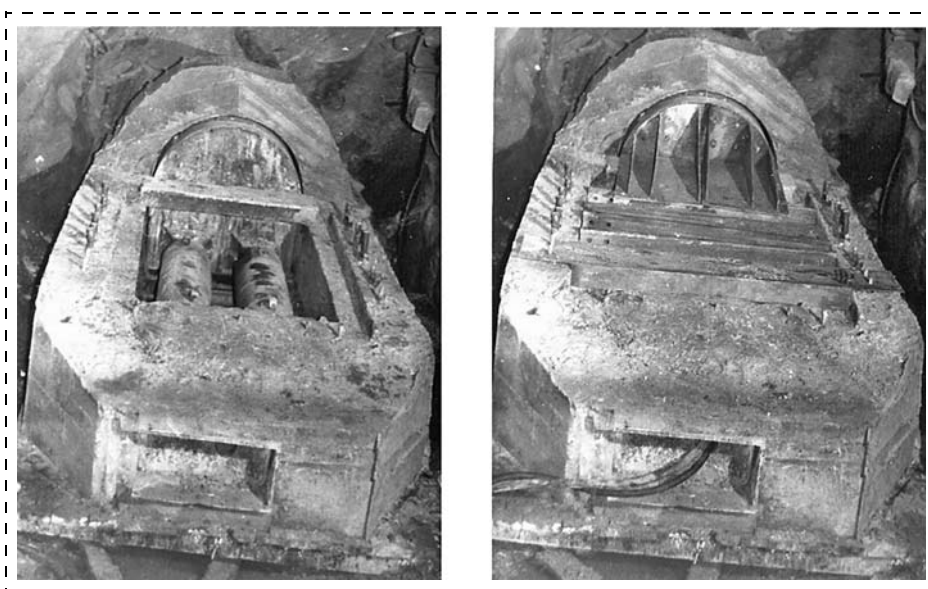
Рис. 2. Внешний вид первого адаптивного железобетонного питателя в шахте
