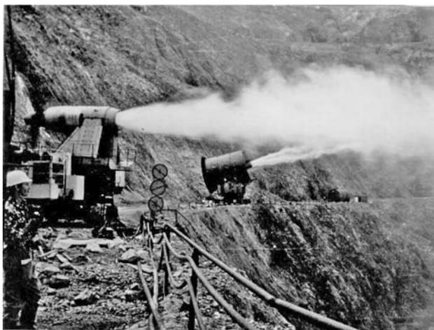
Рис. 3. Активное воздействие воздушно-газожидкостных струй на пылегазовое облако с помощью турбовентилятора-оросителя НК-12КВ-1М
