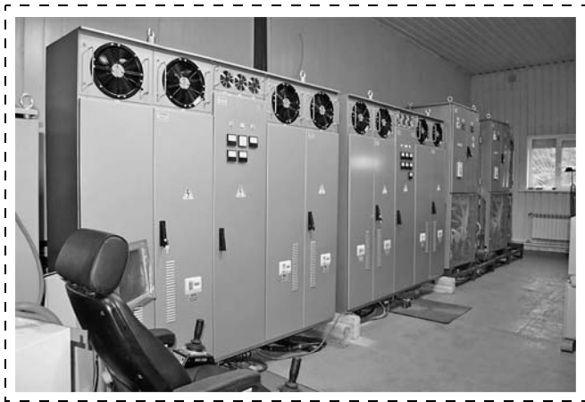
Рис. 1. НКУ для экскаваторов ЭКГ-12К и драглайнов ЭШ-6/45
