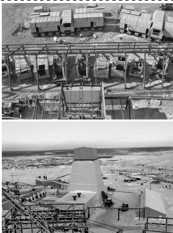
Рис. 3. Строительство рудника "Удачный", Якутия: сверху — монтаж проходческих машин МПП-17,5; внизу — оснащенный для проходки ствол
