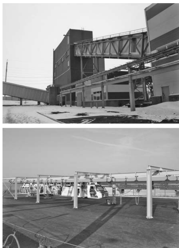
Рис. 1. Строительство шахты "Шерловская-Наклонная": вверху — здание отгрузки угля; внизу — монорельсовая дорога МДК
