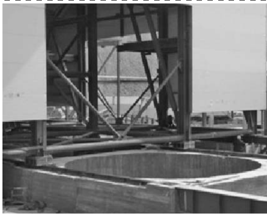
Рис. 2. Работы по продвижке копра скипового ствола при строительстве рудника "Мир", Якутия
