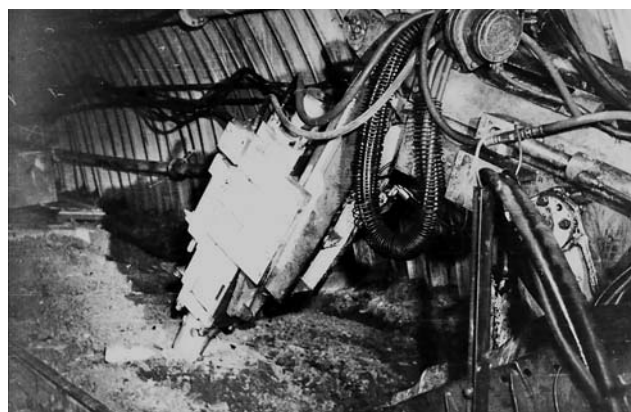
Рис. 2. Манипулятор с гидравлическим молотом на подрывке почвы горной выработки
