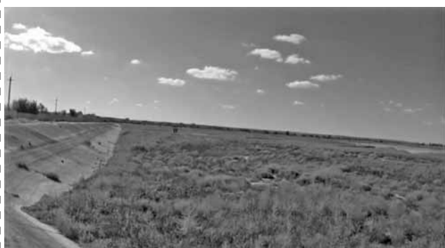
Рис. 7. Вид на 3-е водохранилище, сентябрь 2016г.
