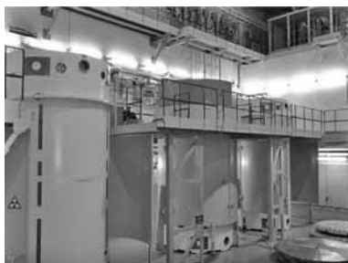
Рис. 6. Пост подготовки УКХ к хранению. Выполняется осушка и контроль герметичности УКХ
