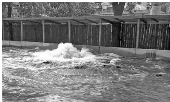
Рис. 2. Последствия аварии на городской водопроводной сети
