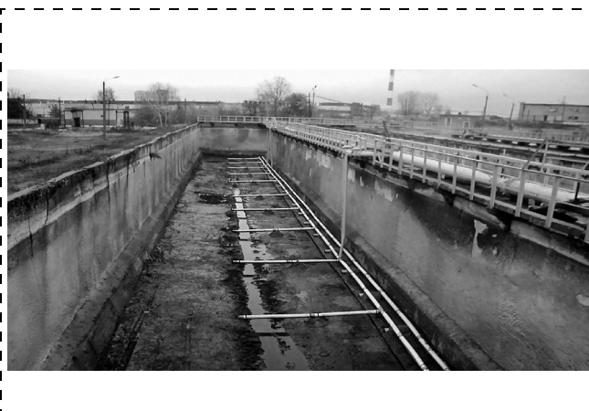
Рис. 4. Модульная сборка аэраторов в аэротенке очистных сооружений г. Дмитровграда
